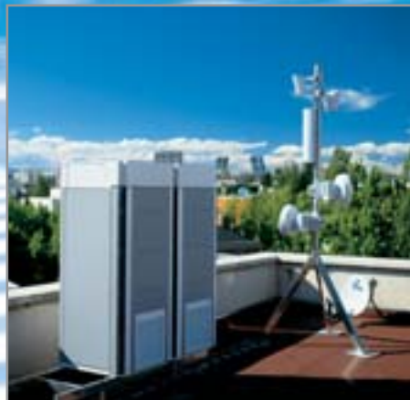
▲ Nokia UltraSite — оборудование для сетей GSM, EDGE и WCDMA
