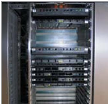
▲ Оборудование для цифровых АТС EWSD CP113C компании Siemens устанавливается в центральных, западных и южных районах столицы
