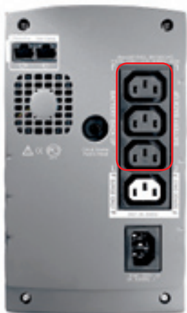
ТРИ РАЗЪЕМА с резервным питанием в сумме обеспечивают ток 4,7 А
