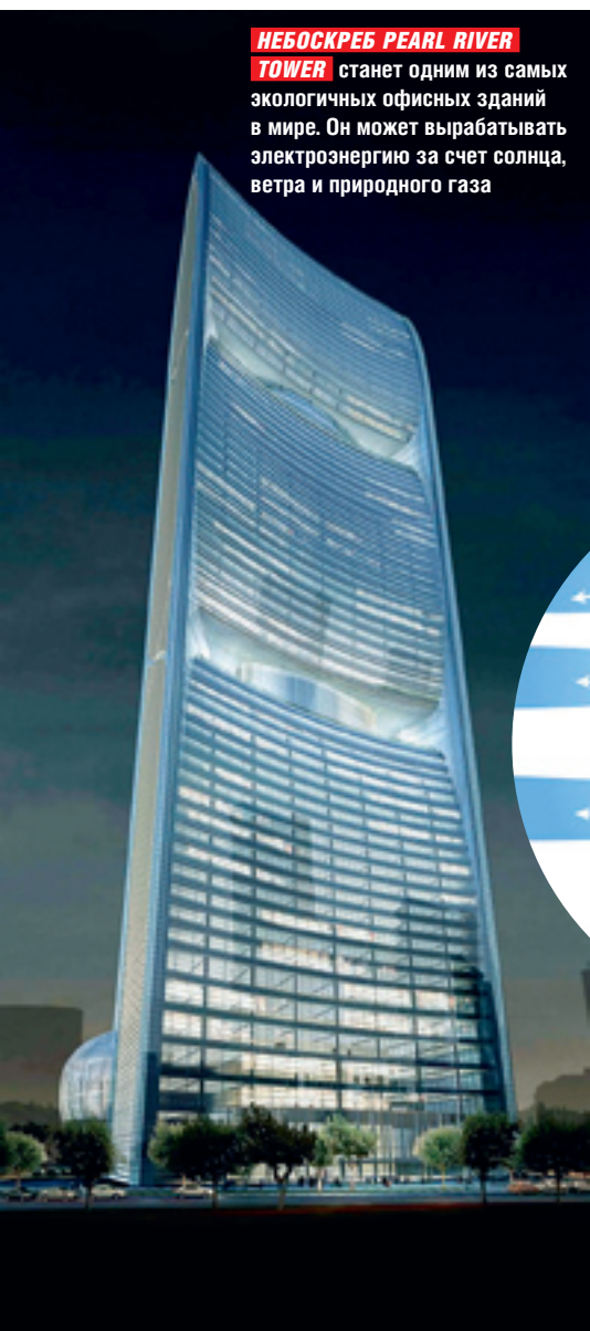
PEARL RIVER TOWER спроектирован таким образом, что увеличивает скорость движения воздушных масс, проходящих через технические этажи, в 15 раз
