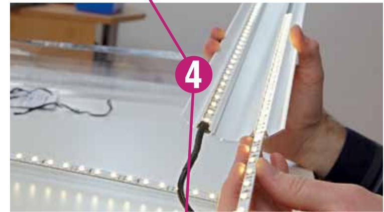
**5 ПРОКЛАДЫВАЕМ КАБЕЛЬ** Установка короба для кабеля Alunovo не составляет труда: вначале закрепите на стене с помощью дюбелей пластиковый канал и поместите в него шнур. После этого наденьте на канал алюминиевую накладку. При проведении работ необходимо позаботиться о том, чтобы кабель-канал был надежно спрятан за телевизором и тумбой и провод не был заметен снизу или сверху. Кабель должен иметь достаточный запас длины, чтобы можно было поворачивать телевизор в стороны.
