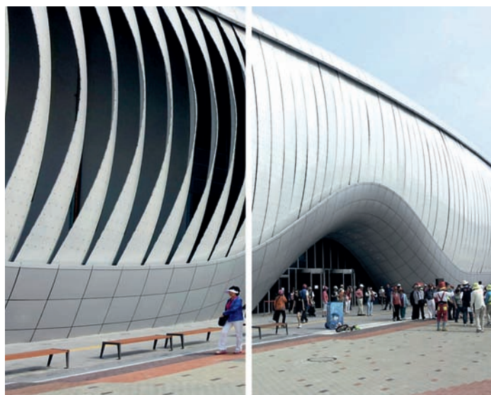
Фасад типа Flectofin, представленный на выставке EXPO 2012, имитирует движение лепестков цветка, которым при открытии и закрытии не требуется большого количества энергии
